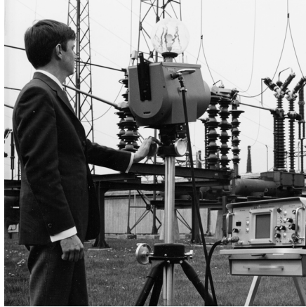
1969년: Thermovision 모델 661. 카메라 무게는 약 25kg, 오실로스코프는 20kg, 삼각대는 15kg입니다. 220VAC 발전기 세트와 액체 질소가 포함된 10L 용기도 필요합니다. 오실로스코프 왼쪽에 폴라로이드 부착물(6kg)을 볼 수 있습니다.
